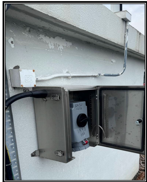
加装的 63 安培三相岸上电源供应
