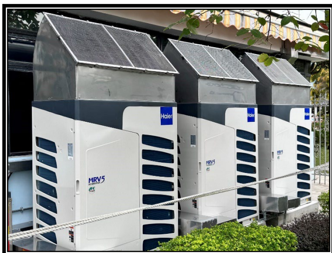
配备变速驱动器机组的可变制冷剂流量系统
