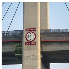
汲水門大橋區域
