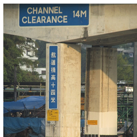
鴨脷洲大橋區域
