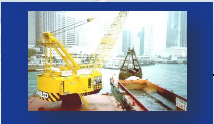
局部挖泥工程 (啓德明渠進口道) Localized dredging (KTAC)
